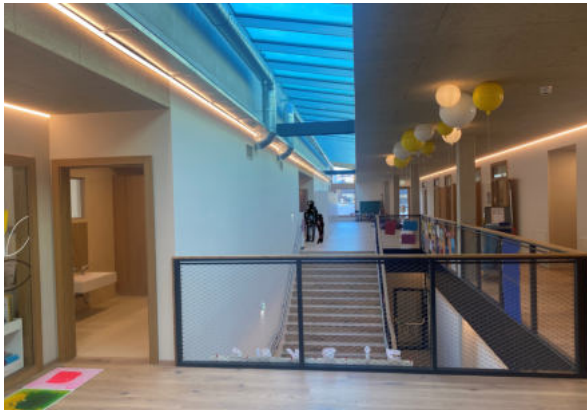
Abbildung 7, 8, 9 und 10: Sichtbare Luftleitungen im Gang bzw. Garderobenbereich
