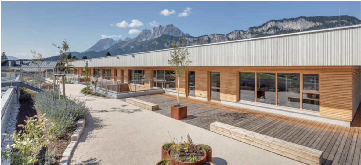
Abbildung 16: Architektur – Bildgalerie KIM
